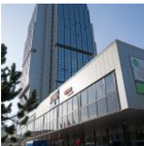
Fassaadiklaasid by Klaasmerk – Hotell Olümpia
