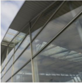
Fassaadiklaasid by Klaasmerk – Audi müügisalong
