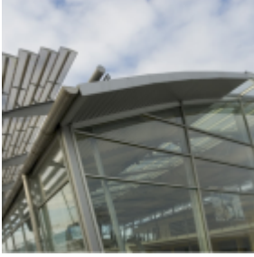
Fassaadiklaasid by Klaasmerk – Audi müügisalong
